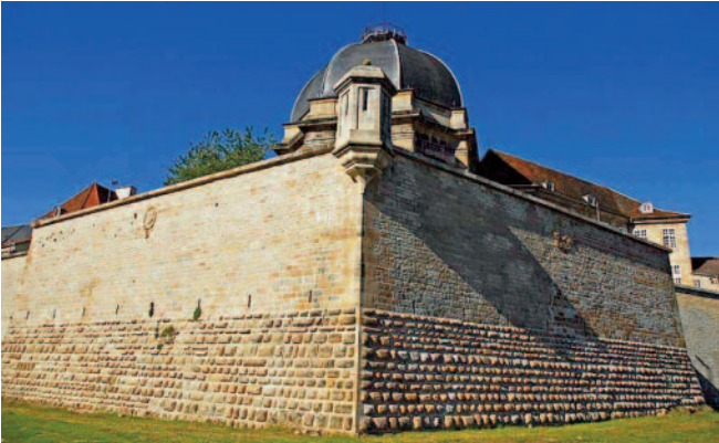
Vue générale de la tour Piquante - © Jean-François Feutriez
