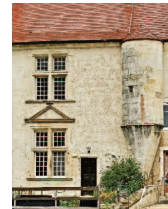
Façade du logis abbatial d'Auberive S. Riandet, service Patrimoine PAH
