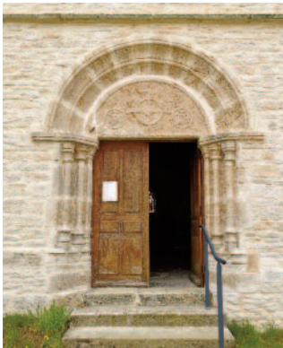
Église de la Sainte-Trinité de Vesvres-sous-Chalancey, portail - S. Riandet, service Patrimoine PAH
