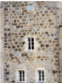
Château de Chalancey : donjon médiéval, bossages rustiques - S. Riandet, service Patrimoine PAH
