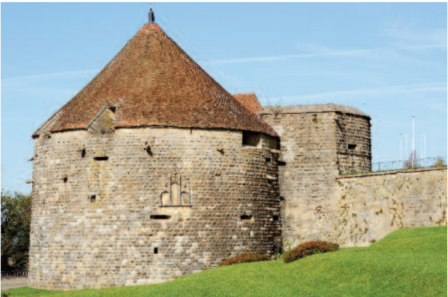
Vue générale des tours de Navarre et d'Orval - S. Riandet, service Patrimoine PAH
