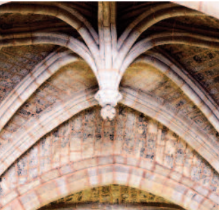
Église Saint-Martin de Langres, clef de voûte pendante - S. Riandet - service Patrimoine PAH
