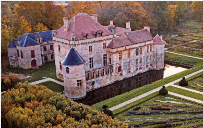
Vue aérienne du château du Pailly - photo T. Jorion, DRAC Grand Est
