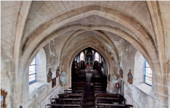
Église Saint-Epvre de Provençères-sur-Meuse, voûte avec arcs à pénétration - S. Riandet, service Patrimoine PAH
