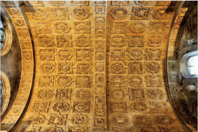
Chapelle d'Amoncourt dans la cathédrale de Langres, voûte à caissons sculptés S. Riandet, service Patrimoine PAH
