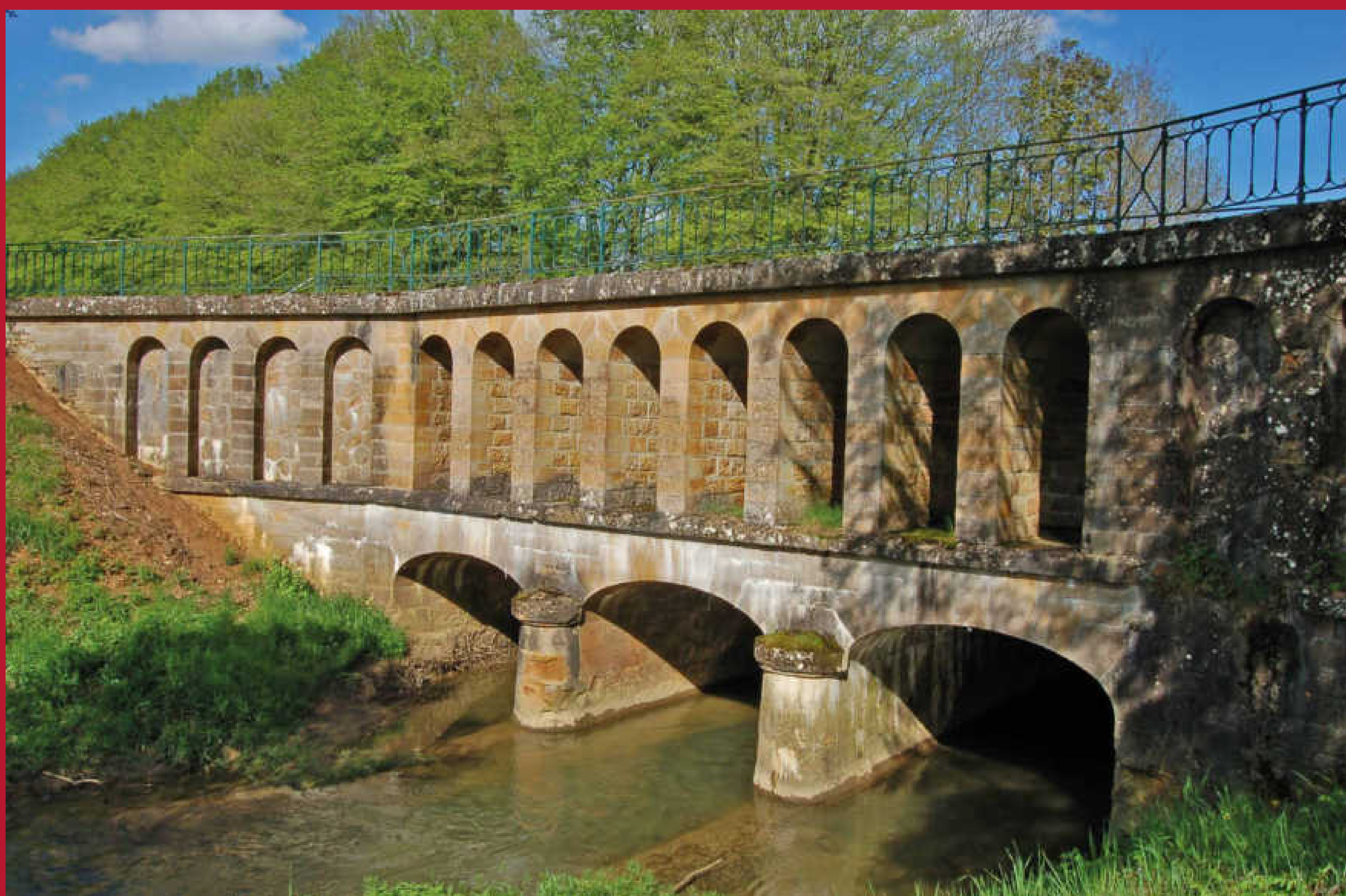
5- Pont-canal à Cusey - Gérard Féron
