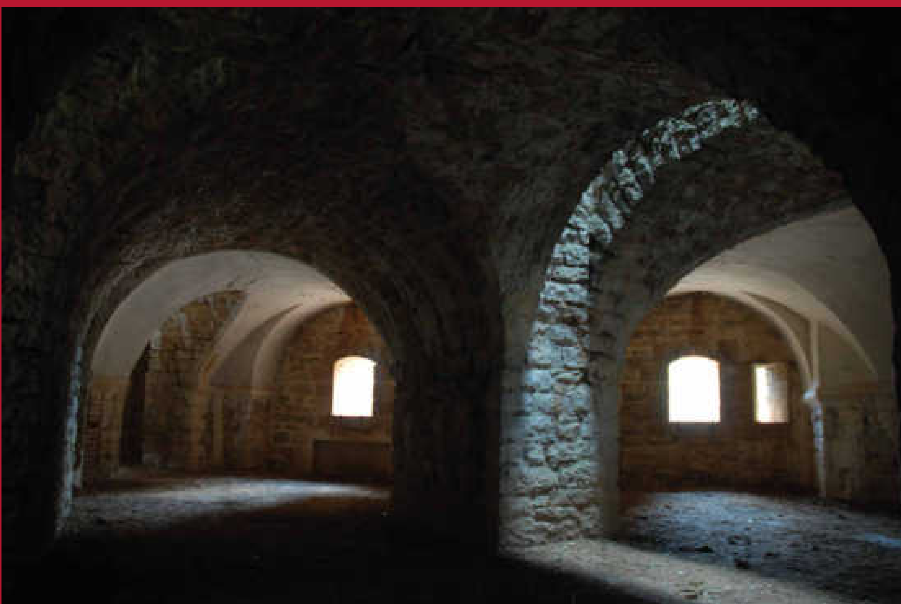
6 - Vue d'une caponnière du fort de la Pointe à Saint-Ciergues - JF Feutriez, Office de Tourisme du Pays de Langres
