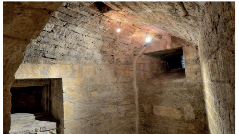
Casemate de la salle basse de la tour Saint-Ferjeux. Ces chambres de tir étaient équipées de pièces d'artillerie modestes (environ 1 mètre) destinées à flanquer les courtines adjacentes grâce à des tirs à courte portée (environ 200 mètres). L'embrasure de tir (en bas à droite) a été bouchée ; l'ouverture qui la surmonte ainsi que celle au sommet de la voûte sont des événements qui devaient évacuer les fumées dégagées par les tirs.
