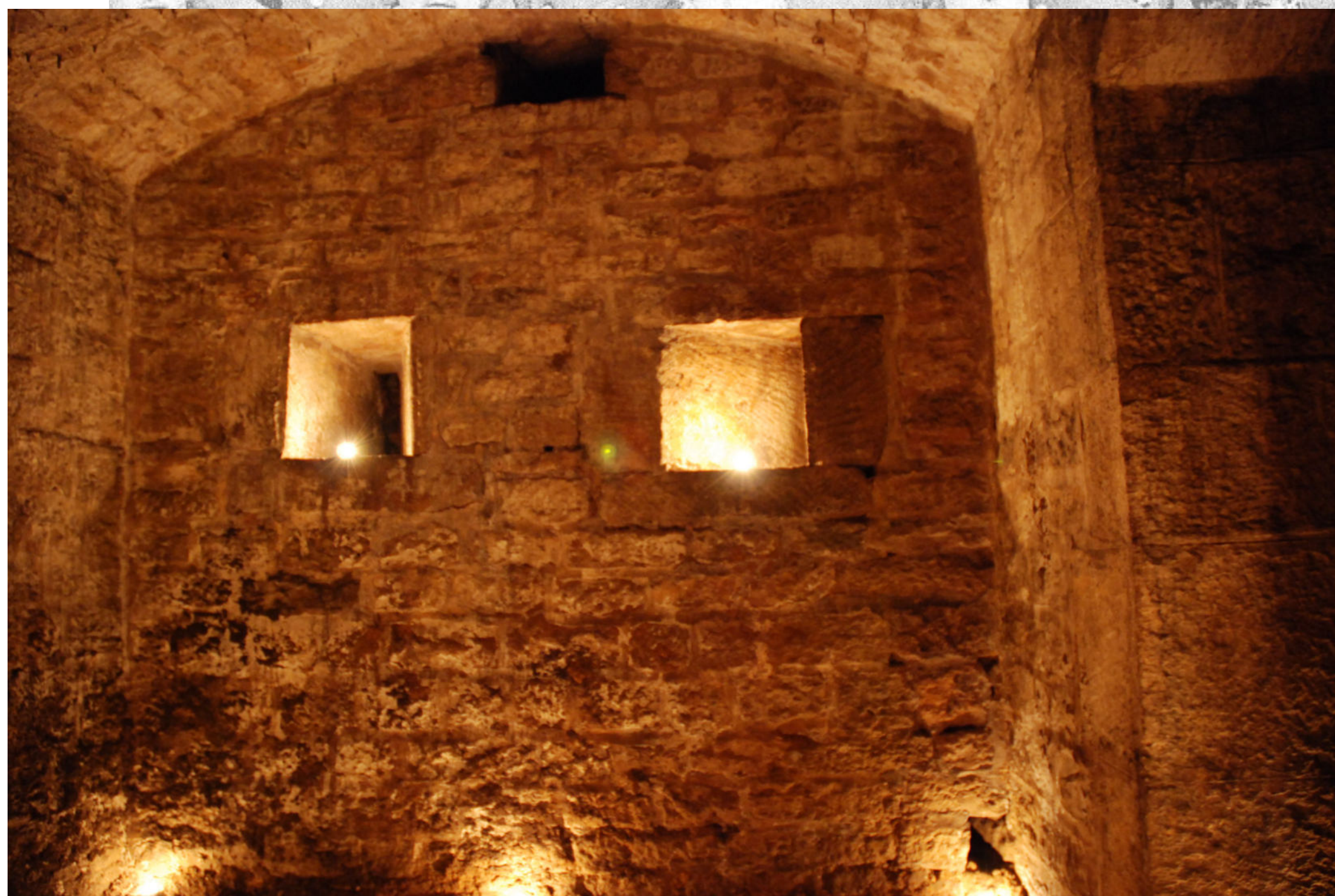
Une des 54 casemates de la galerie de fusillade équipée de ses 2 créneaux de tir (cliché Sylvain Riandet)
