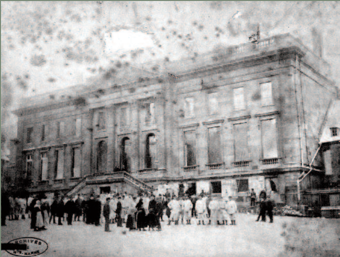
Photo prise après l’incendie de l’hôtel de ville. 5 décembre 1892. Conseil Départemental de la Haute-Marne (Archives Départementales), liasse 4N42. Sur cette photographie prise peu de temps après l’incendie on mesure l’étendue des dégâts : le bâtiment n’a plus ni toiture, ni menuiseries. Au premier plan, habillés en blanc, les pompiers de la Ville posent pour la postérité...
