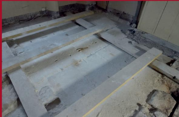
Travaux de renforcement de la voûte plate par remplacement des agrafes et rejointolement des dalles (mars 2018 - photo Sylvain Riandet)
