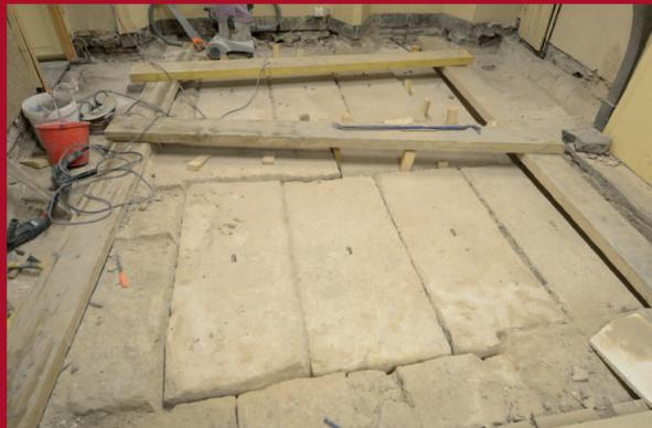
Travaux de renforcement de la voûte plate par recalage des dalles en partie supérieure (mars 2018 - photo Sylvain Riandet)
