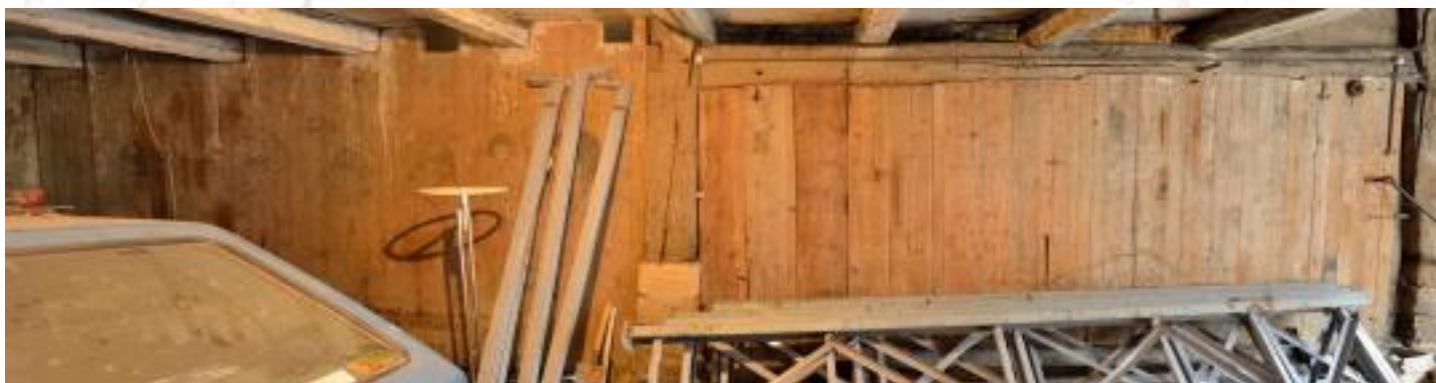
Cloison de 1916 en place dans le garage - Sans la générosité de ce particulier, la cloison serait restée inconnue.
