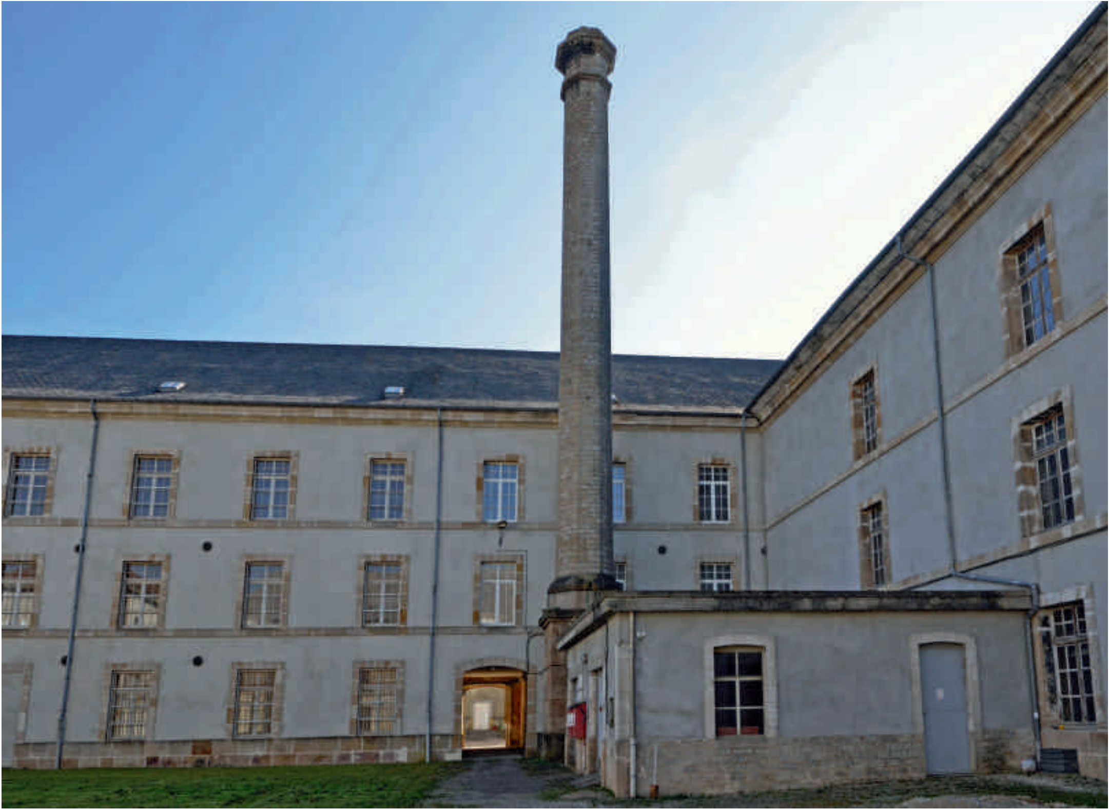
Bâtiments de la manutention - © Ville de Langres, Sylvain Riandet Avec environ 10000 m² d’espace de stockage, la Manutention est identifiable avec sa cheminée en pierre visible dans sa partie haute depuis la route.
