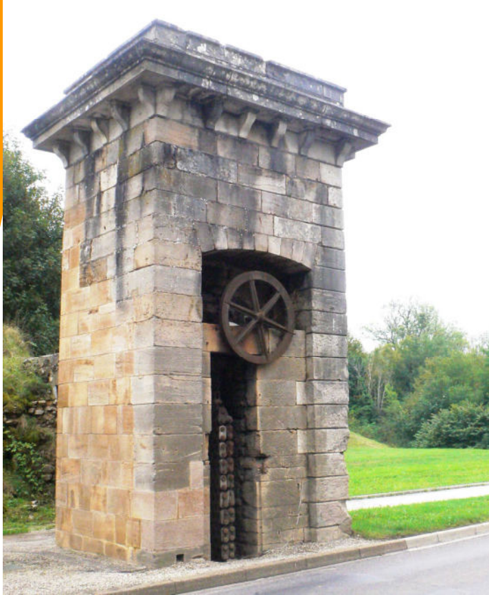
Détail du pilier est de la porte sud de la citadelle
