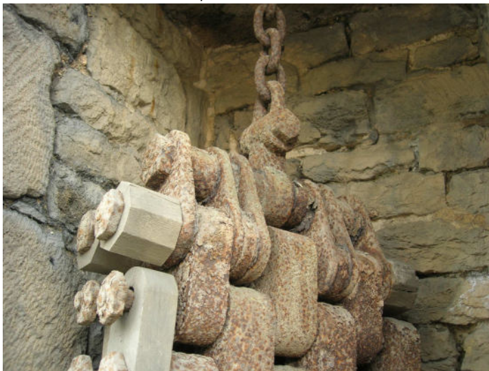
Détail de l'accroche du contrepoids
