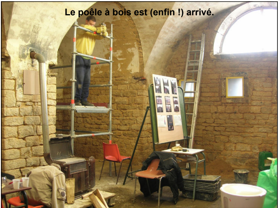
Après les joints, Christophe, Armayis et Dominique s'attaquent aux enduits à la chaux
