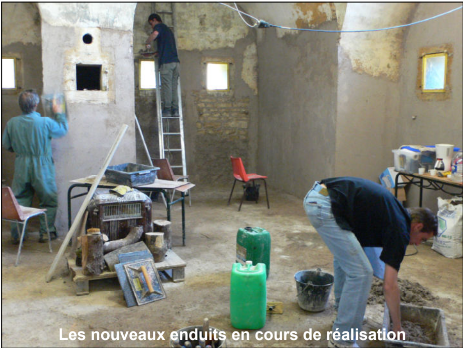
Damir et Abdel travaillent les enduits à la chaux
