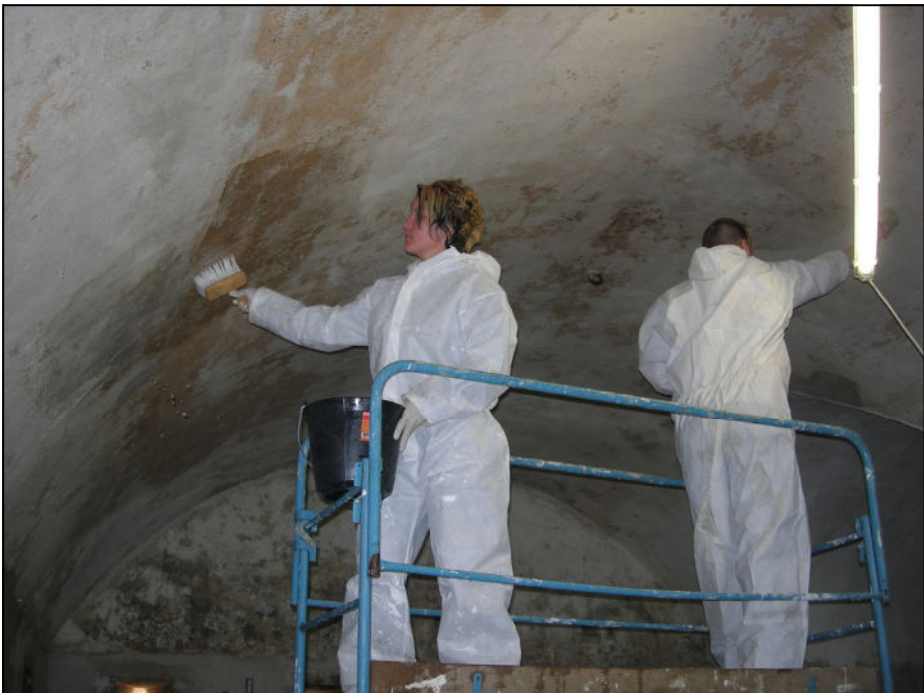
Les nouveaux enduits en cours de réalisation
