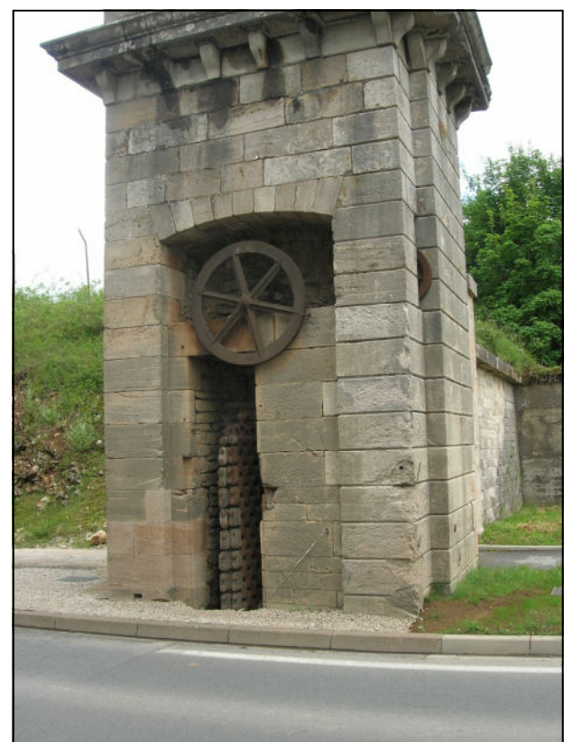
Vestiges du système de pont-levis à la Poncelet encore en place aux portes de la citadelle
