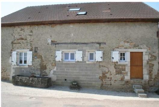
Exemple de fermeture de porte de grange par une maçonnerie qui ne marque pas de retrait : dispositif interdit et préjudiciable à la lisibilité de la façade
