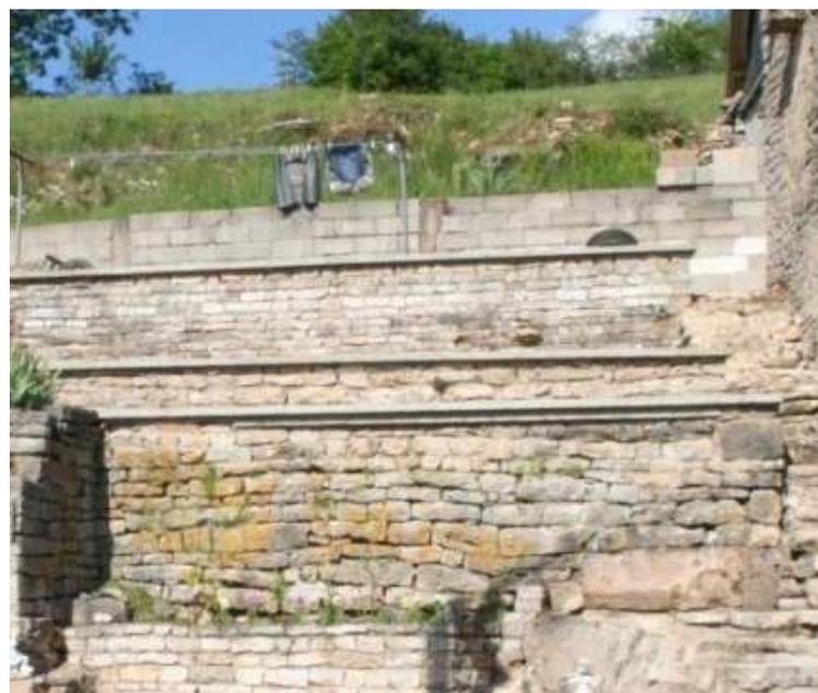
Contre-exemple : soutènements jointoyés, couvertines préfabriquées et reprise en parpaings de béton. Dispositifs interdits par le PVAP.
