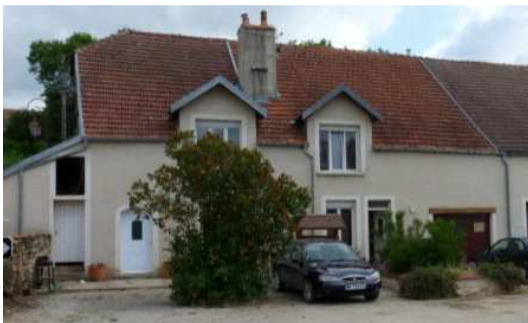
Lucarnes pendantes créées en toiture
