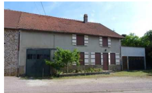
Annexe accolée au mur pignon
