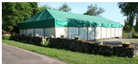
La perte de l'arase entraîne la dislocation progressive des lits inférieurs et l'irrégularité du mur
