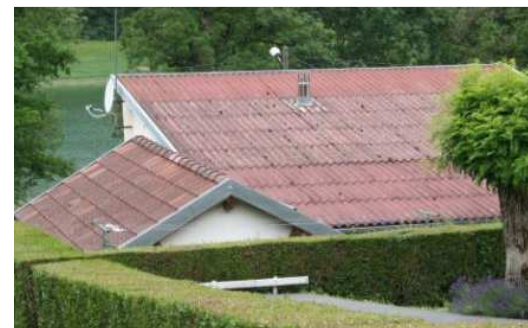
Couverture en bande ondulée - maison de pêcheurs à Perrancey
