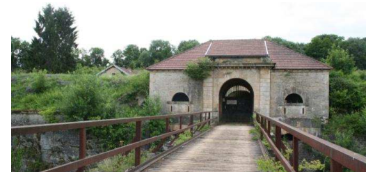
Entrée du fort de la Bonnelle
