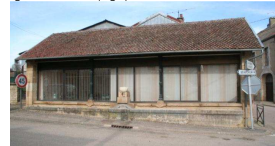
Lavoir de Hûmes à piliers de fonte fin du XIX ème siècle
