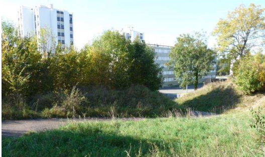
Percement des bastions de la citadelle
