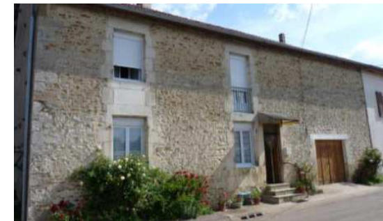
Enduit beurré – ferme rue des acacias à Jorquenay
