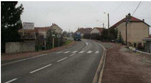
Traitement routier de la chaussée bloquant le passage des piétons
