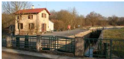
Maison éclusière à Hûmes
