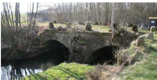
Pont sur la Marne à Champigny
