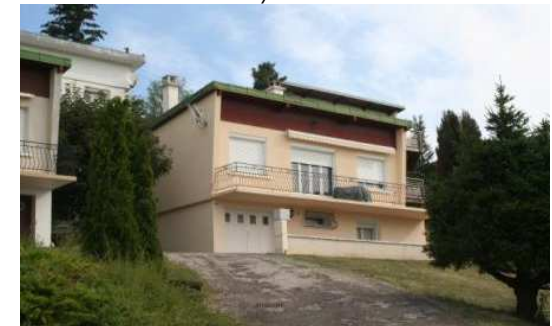
Maison de pêcheurs en béton rue de la côte de Recey à Peigney
