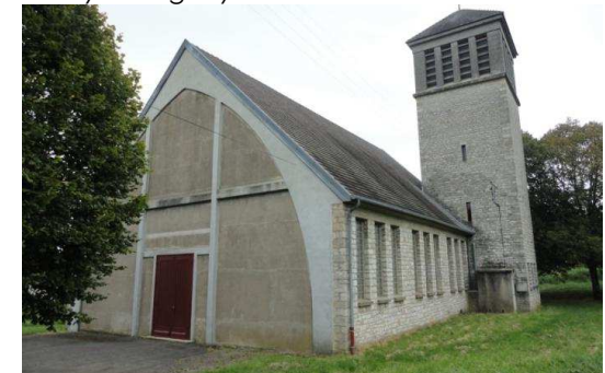
Eglise à structure béton du faubourg Saint-Gilles à Langres
