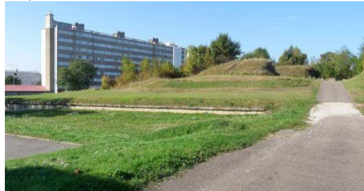
Logements en barre face à la citadelle
