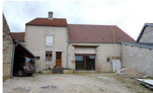
Porte de grange repartitionnée
