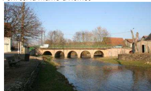
Pont sur la Mouche à Hûmes
