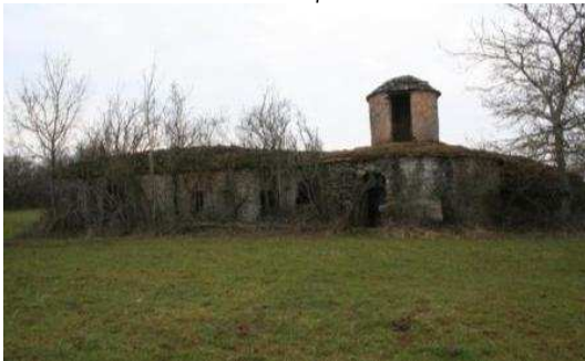
Chapelle de Chardonville construite en pierre sèche
