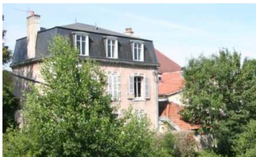
Couverture en ardoise - logement patronal du Moulin Rouge
