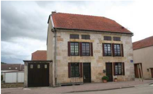
Façade en pierre de taille rue du 152ème R.I. à Hûmes
