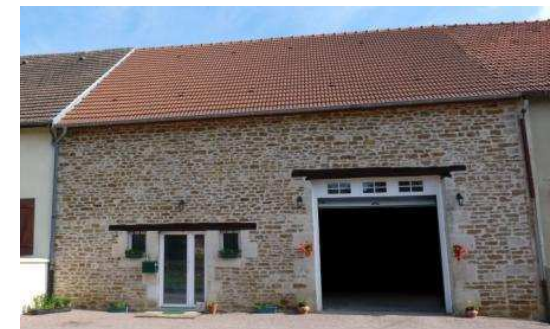
Moellons laissés apparents - ferme rue des acacias à Jorquenay
