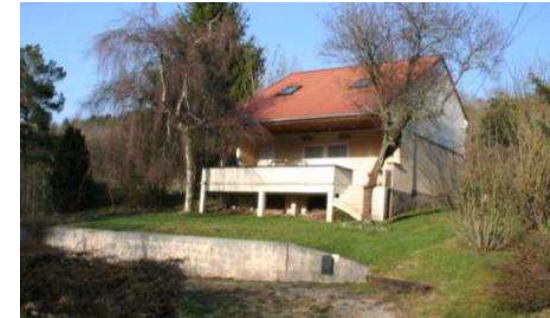
Surélévation avec forme de toit inadaptée
