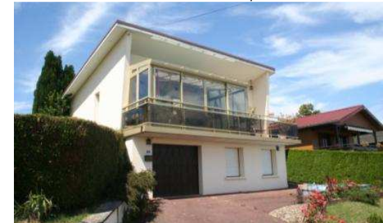
Construction d'une véranda vitrée sur la terrasse
