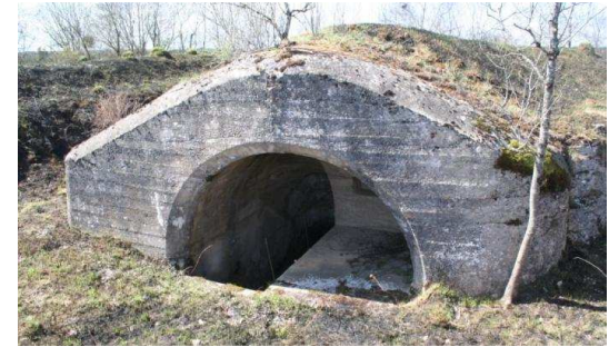
Entrée bétonnée de l'ouvrage d'infanterie de Perrancey
