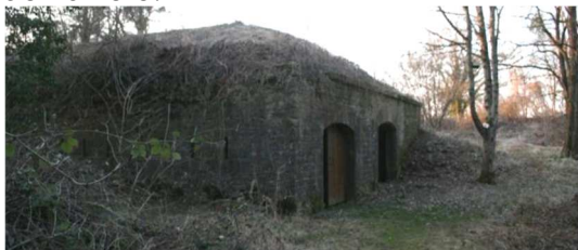
Casemate de la batterie de Hûmes
