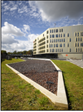
Massif d'infiltration à forte porosité
