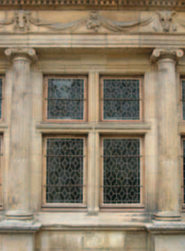
Fenêtre en façade de la Maison Renaissance, XVI e siècle (meneau en pierre).
