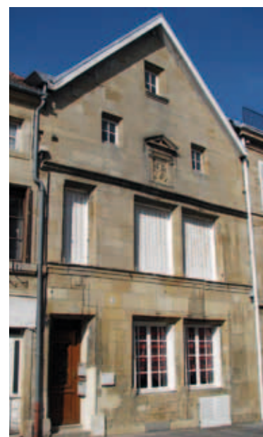
Maison Renaissance du XVI e siècle, rue Barbier-d'Aucourt.
