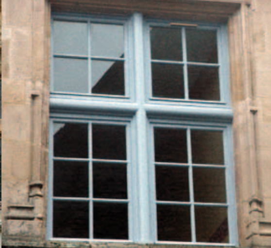
Fenêtre en façade arrière, XVII e siècle (meneau en bois, croisée), rue Saint-Didier.
