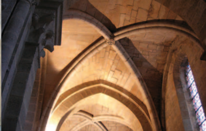
Voûte de la cathédrale Saint-Mammès.
