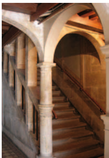
Escalier du XVI e siècle, rue Jean Roussat.
