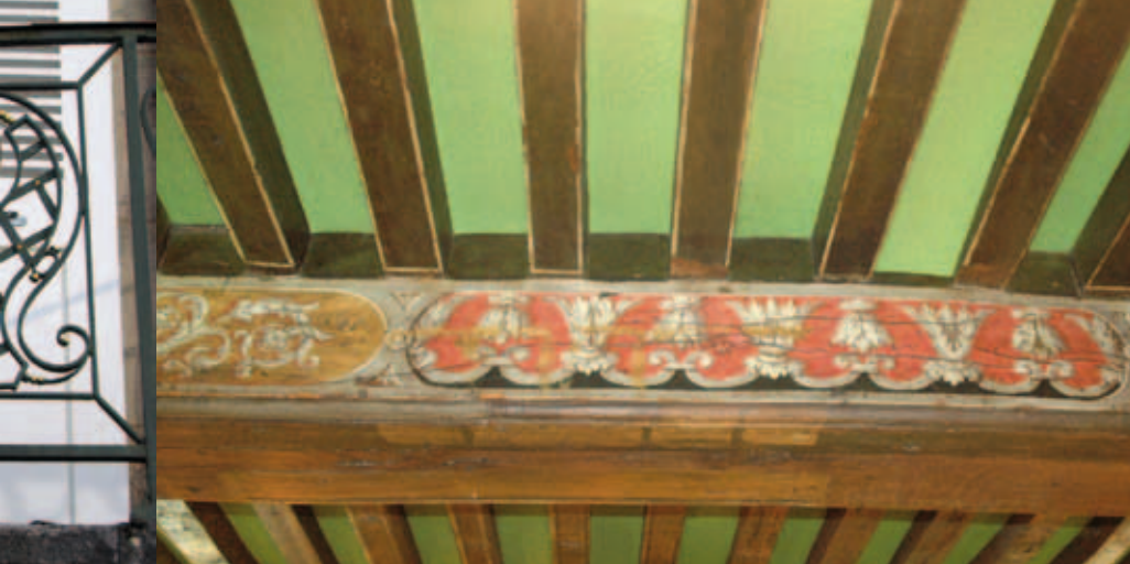
Plafond époque Renaissance, XVI e siècle, rue Diderot.
