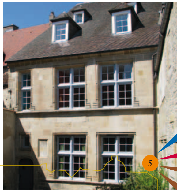
Façade XVI e siècle, rue Saint-Didier.
