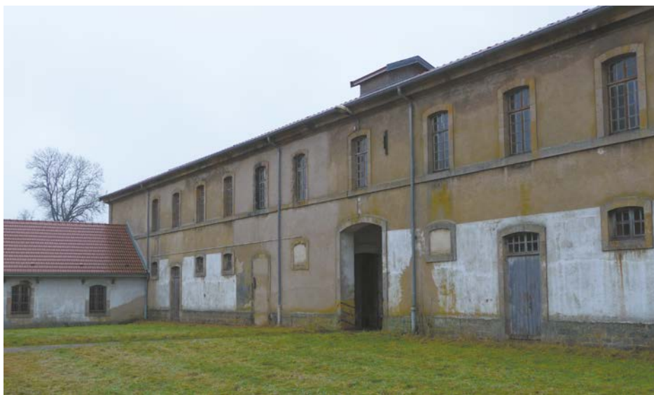
L'actuel bâtiment avant travaux.
