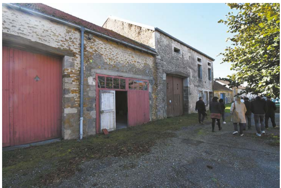
Neuilly-l'Évêque : bâtiment actuel à rénover et transformer en école.
